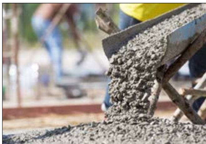
Применение гиперпластификатора позволяет снизить водопотребность на 35%, расход цемента в бетонной смеси на 30%.
